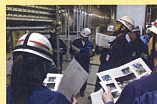
参加者全員による危険箇所確認している様子
