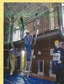
セーフティブロック使用実習の様子
