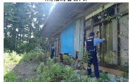
避難指示区域等のパトロール (南相馬署管内)
