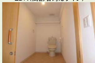
介助スペースを考慮した広いトイレ。高齢者対応住戸は全て引き戸を採用。
