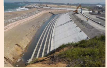
堤防護岸の整備(新地町 木崎地区)
