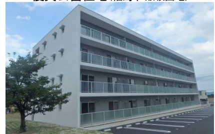
復興公営住宅(福島市 飯坂団地)
