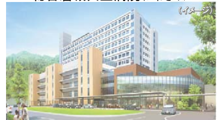
総合磐城共立病院（いわき市）
