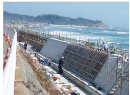
海岸堤防の整備(いわき市永崎地区)
