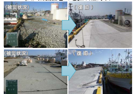
松川浦漁港の復旧(相馬市)
