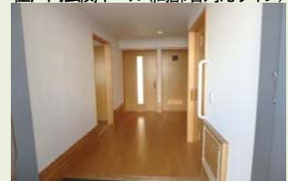
1階が高齢者対応住戸。玄関より住戸内へは段差を無くしたバリアフリー設計。
