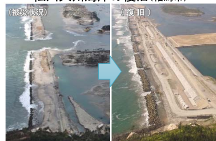
松川大州海岸の復旧(相馬市)
