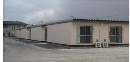
応急仮設住宅(郡山市 南一丁目)
