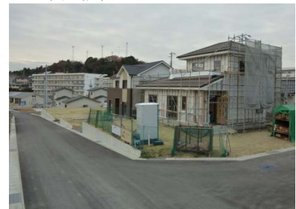
集団移転のための宅地造成
