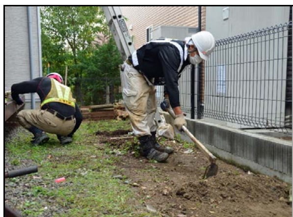
住宅除染での表土の剥ぎ取り作業
