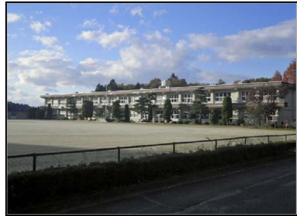
除染現場 (山白石小学校)
