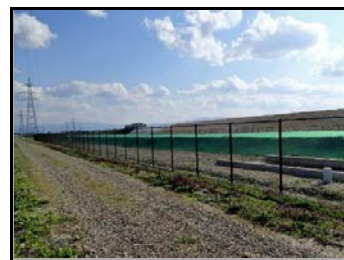
仮置場 保管状況
