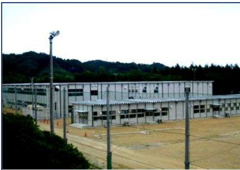
湯本高校の仮設校舎
