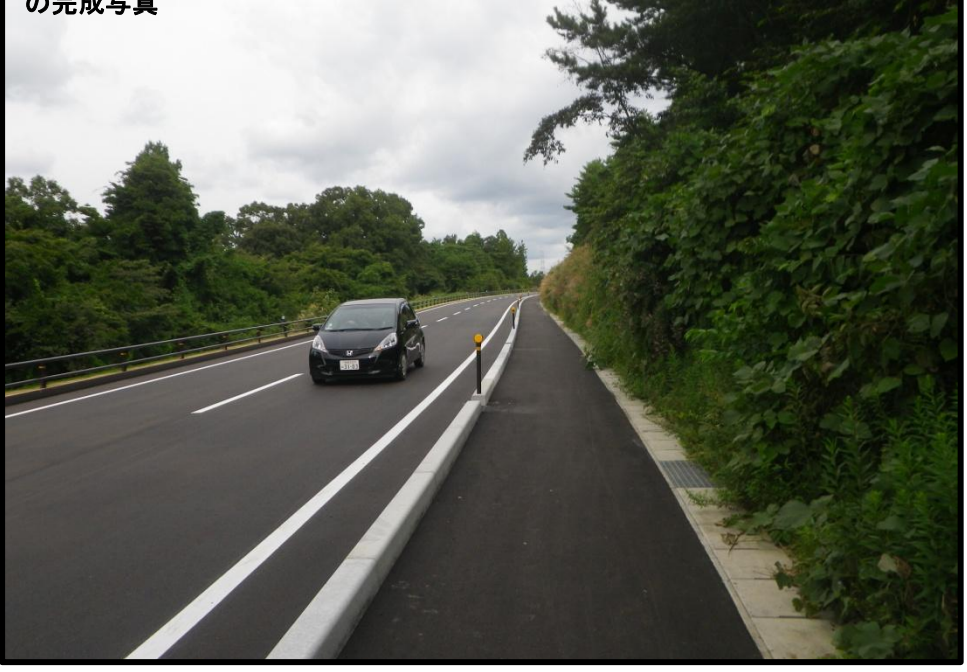
「40952 道路 県道広野小高線(北迫工区)」の完成写真
