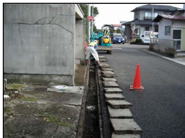
仁井田地区内側溝除染作業
