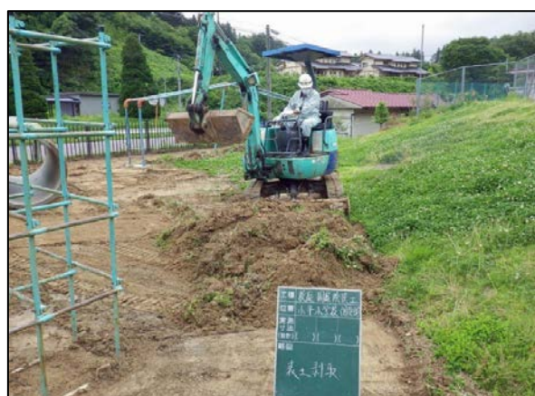
校庭除染工事表土剥取
