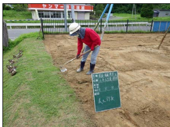
校庭除染工事表土剥取
