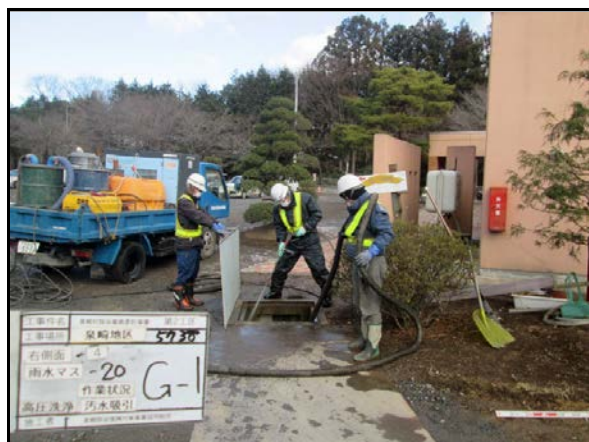
柵除染作業状況
