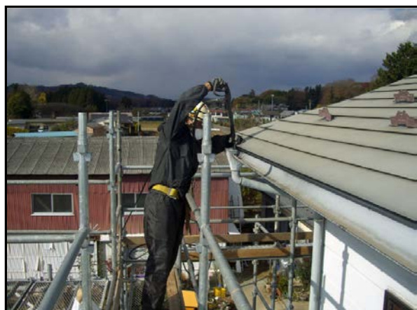
縦樋除染作業状況
