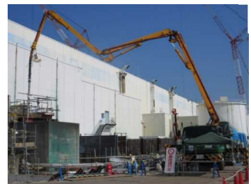
<トレンチ内部充填・閉塞の状況>
