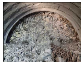
写真1 亀裂の非常に多い安山岩の様子 ※岩塊は小割りしていない
