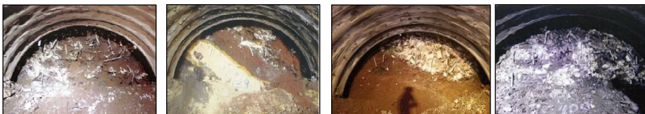
写真2 南倉沢トンネルの切羽状況
