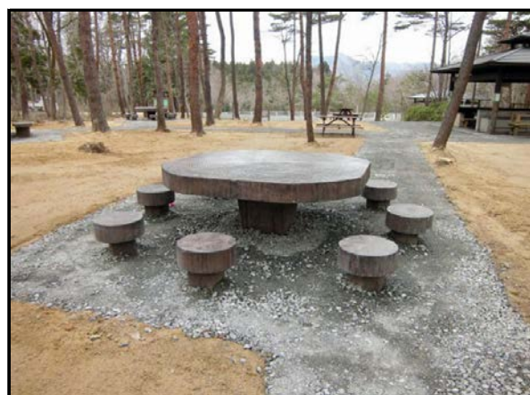
除染完了後状況(公園施設)
