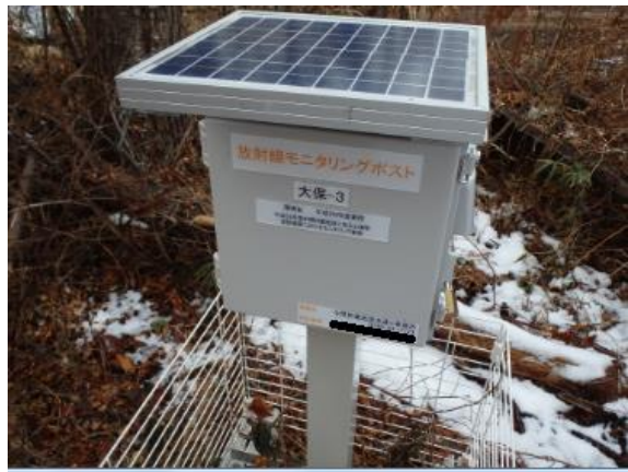
モニタリングポストの設置状況確認
