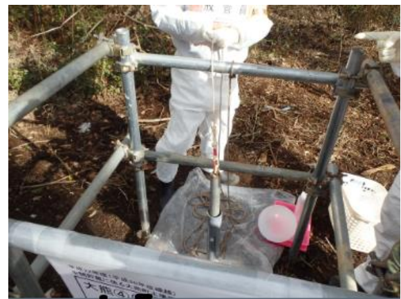
地下水観測井の確認
