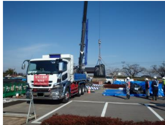
除去土壌等の積み込み作業
