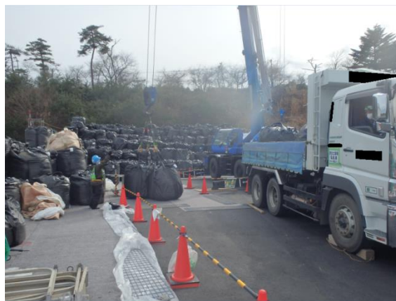
除去土壌等の積下ろし作業
