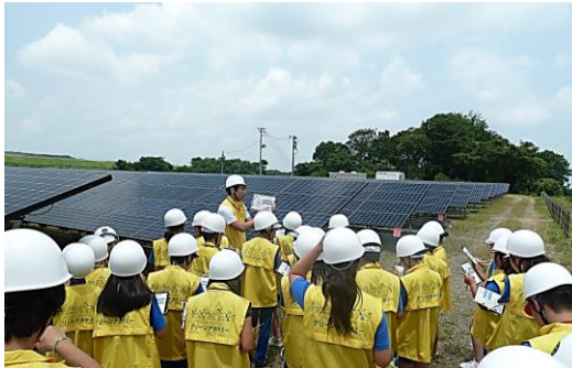
福島空港メガソーラー（須賀川市／玉川村）
