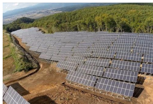
雄国発電所（喜多方市）
