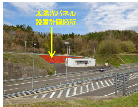
あぶくま高原道路・川辺トンネル付近（玉川村）
