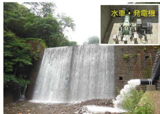
土湯温泉東鴉川水力発電所（福島市）
