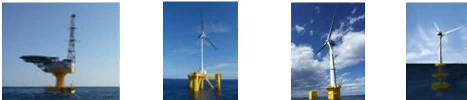
浮体式洋上風力発電実証事業における洋上変電所と洋上風車
