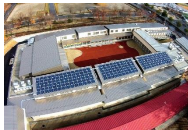
大笹生学園(屋根貸しソーラー)
