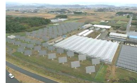
とまとランドいわき (固定型560kW H26.5稼働) (営農型416kW H26.9稼働) いわき市
