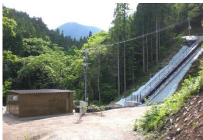
花の郷水力発電所 (175kW、H27.6稼動)下郷町
