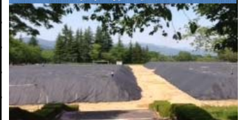
仮置場の状況
