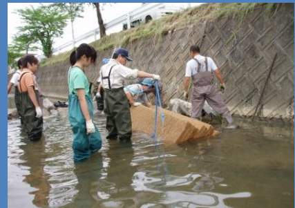
水草の基盤材（ヤマト）設置
