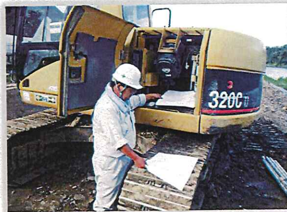
燃料吸着マット設置状況
