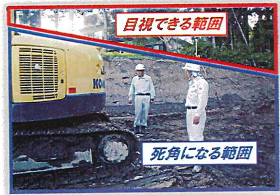
重機死角の確認
