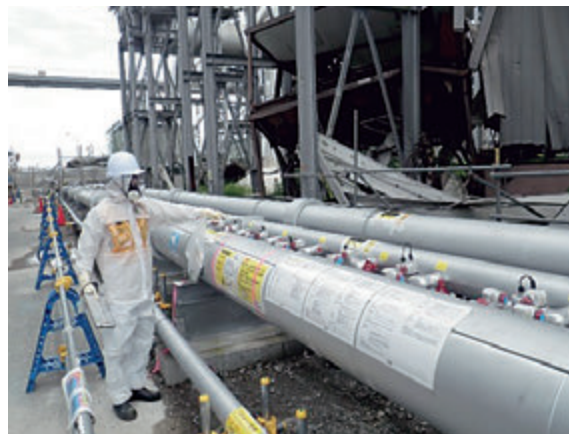
陸側遮水壁試験凍結箇所（No.16）の状況確認
