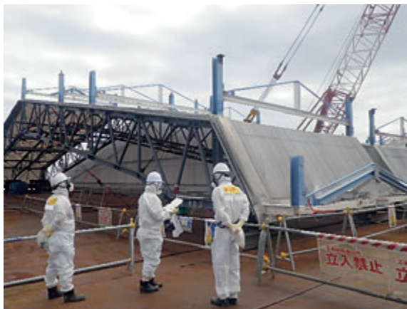
1号機原子炉建屋カバー屋根パネルの保管状況確認
