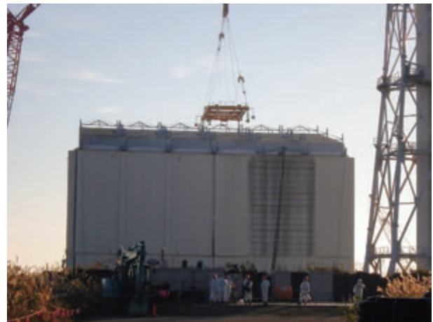
1号機カバー屋根パネル解体に立ち会う 廃炉安全監視協議会
