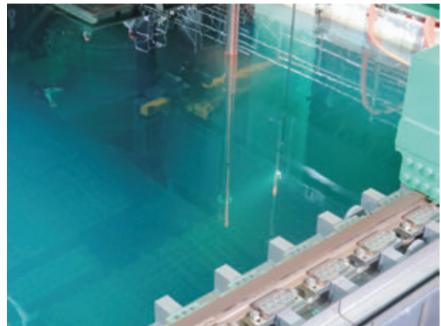
4号機使用済燃料プールの燃料移動 (撮影：東京電力(株))
