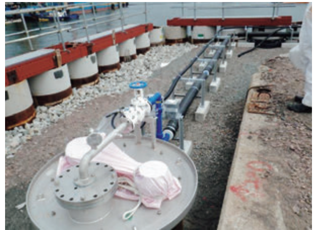
海側遮水壁と地下水ドレンポンド
