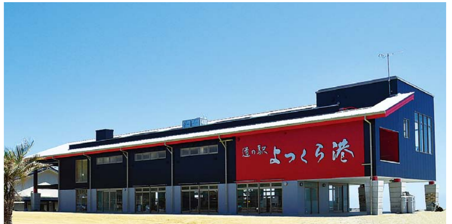
いわき市 新しく生まれ変わり再オープンした道の駅よつくら港(平成24年8月撮影)
