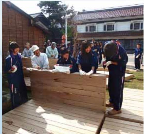
蔵の周囲に芝生を張り、木製デッキを併設しました。
