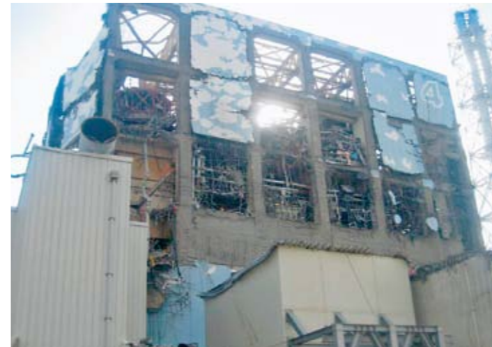
爆発後の第一原発4号機の外観(写真提供:東京電力株式会社)
