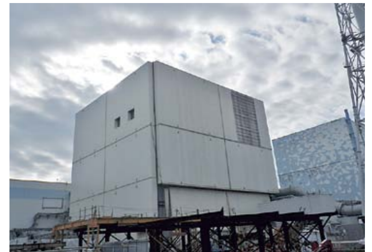
第一原発1号機の外観(平成27年10月撮影)
