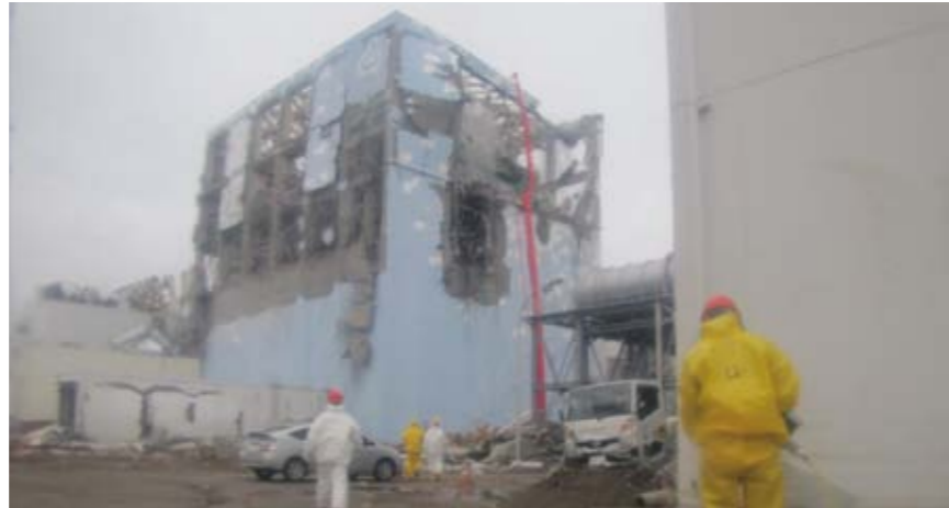
第一原発4号機に放水車から注水(写真提供:東京電力株式会社)
