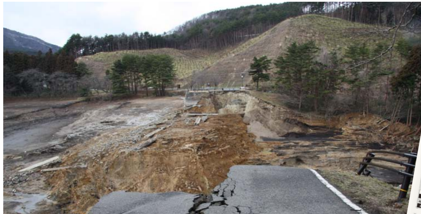
須賀川市 地震により決壊した藤沼湖(写真提供:県警察)
