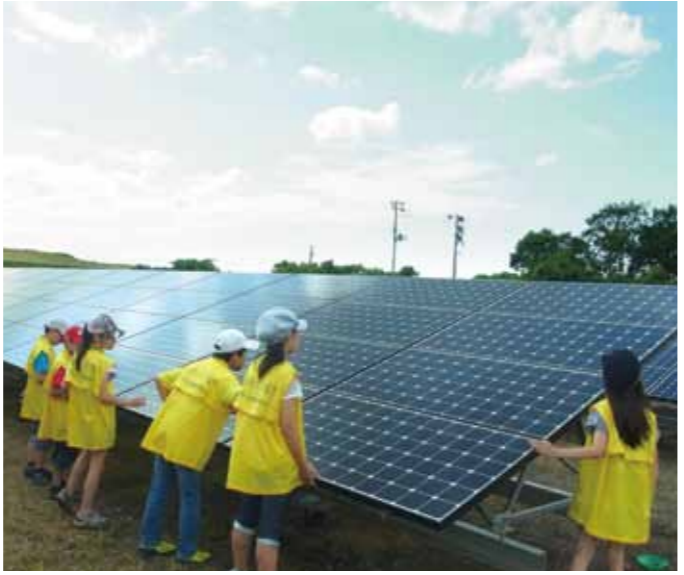
玉川村 福島空港敷地内に「福島空港メガソーラー」が竣工
