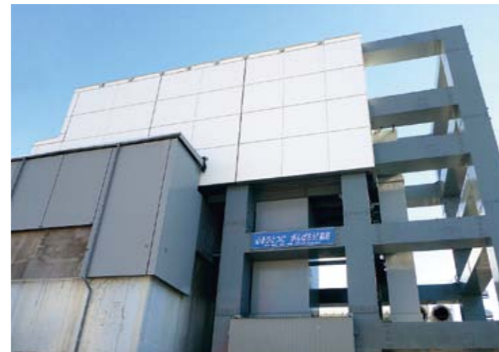
第一原発4号機の外観(平成25年10月撮影)
