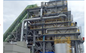
浪江町仮設焼却炉
