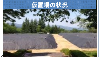
仮置場の状況
