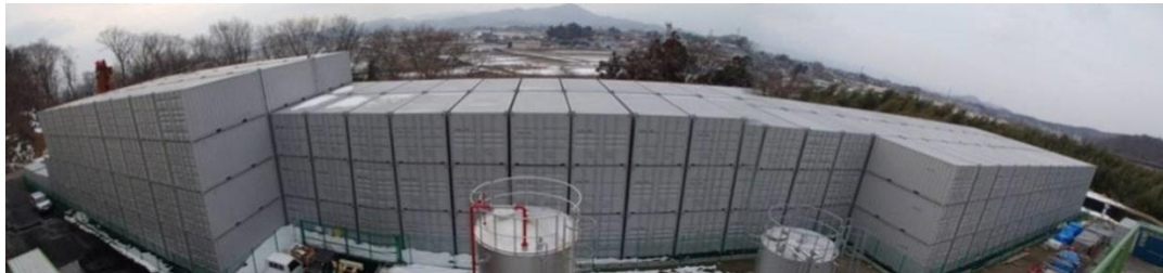
環境省事業で発生した焼却灰保管用20ftコンテナ (最大4段積)
