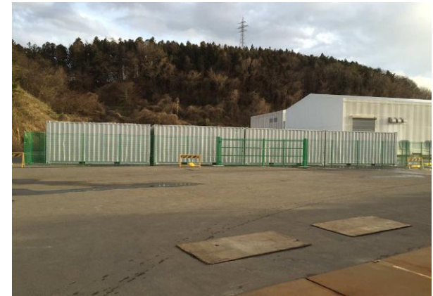
福島県事業で発生した焼却灰保管用 20ftコンテナ (平置き)
