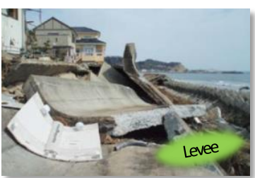
Iwaki city Levee
