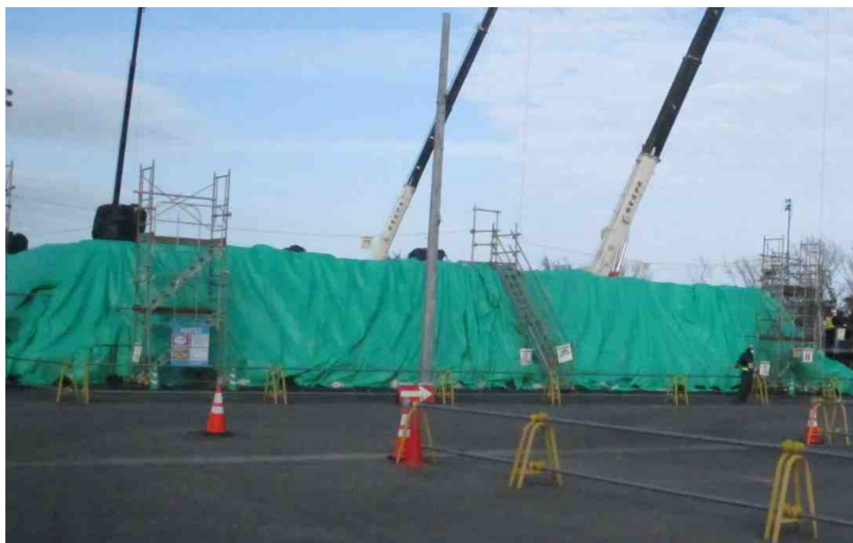
搬入中における遮水シートの状況
