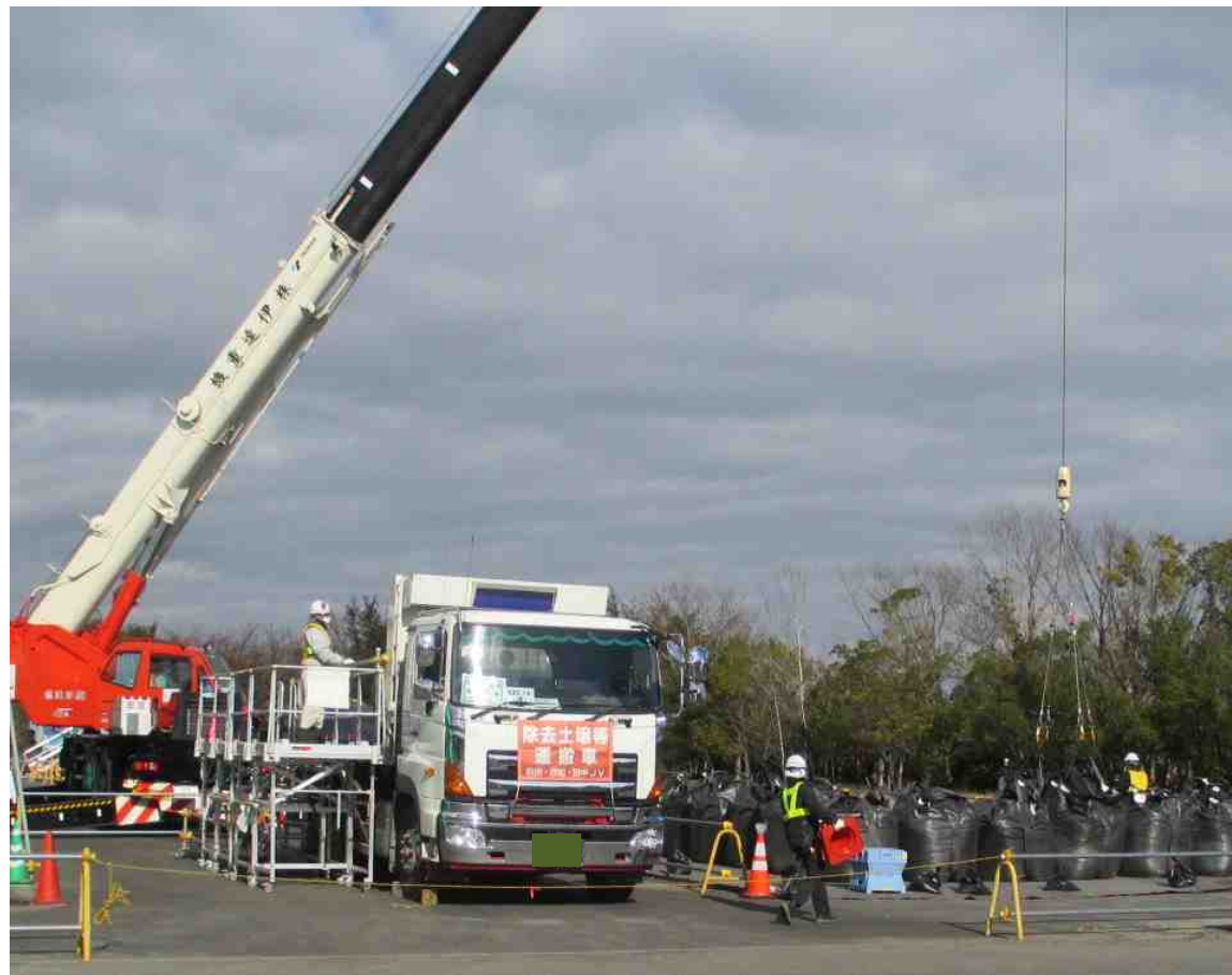
クレーンによる作業状況
