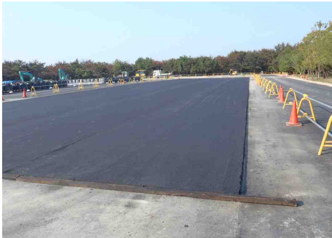
保管場の舗装状況
