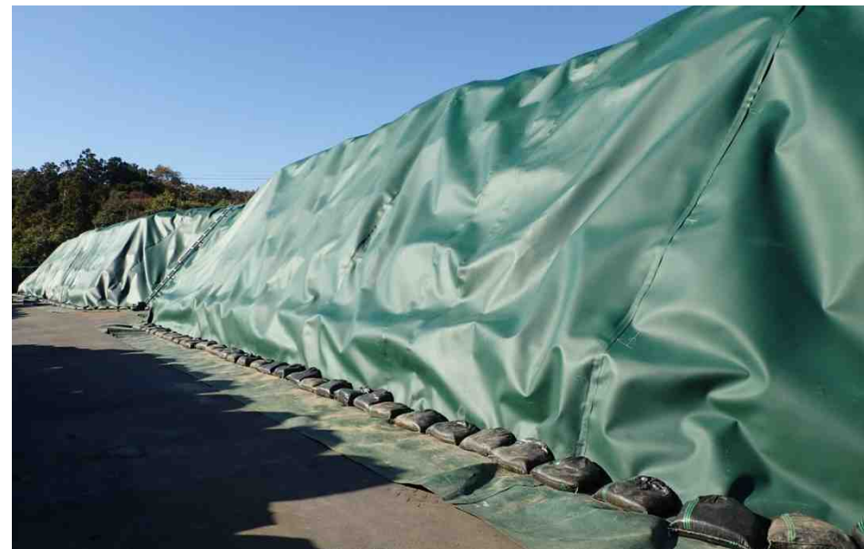
搬入完了後（一山完成後）における 遮水シートの状況
