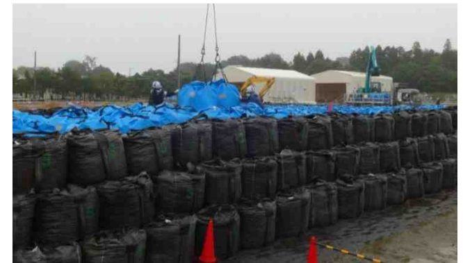
保管場への定置作業
