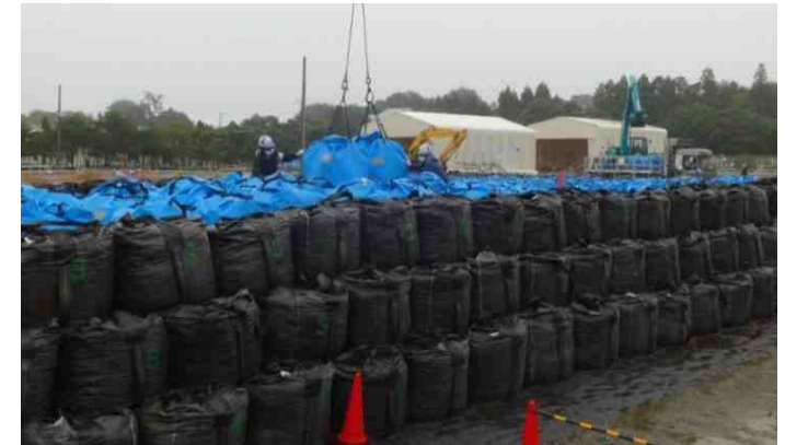
保管場への定置作業
