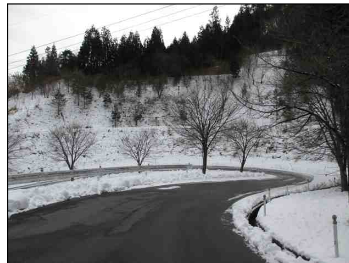
除雪後の輸送路(小野町)
