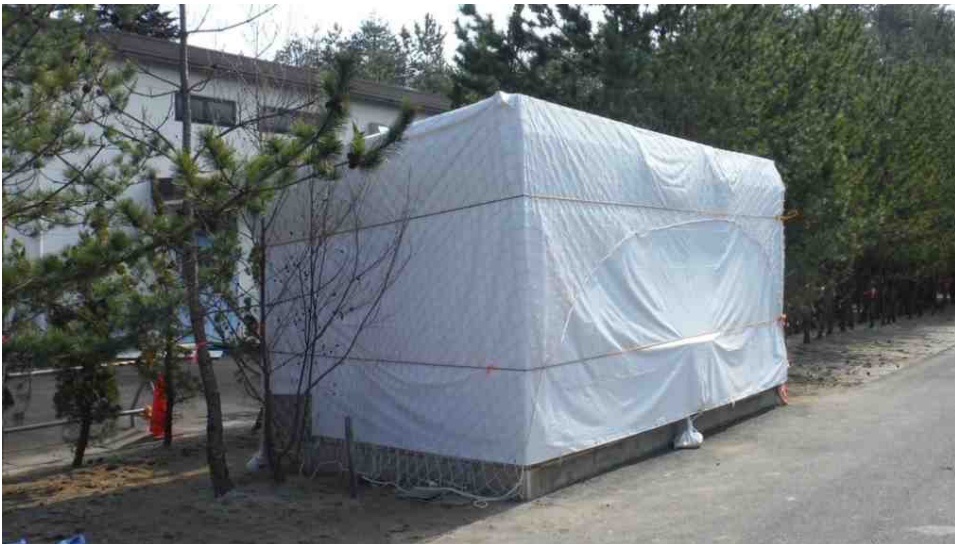
養生後の倉庫の状況
