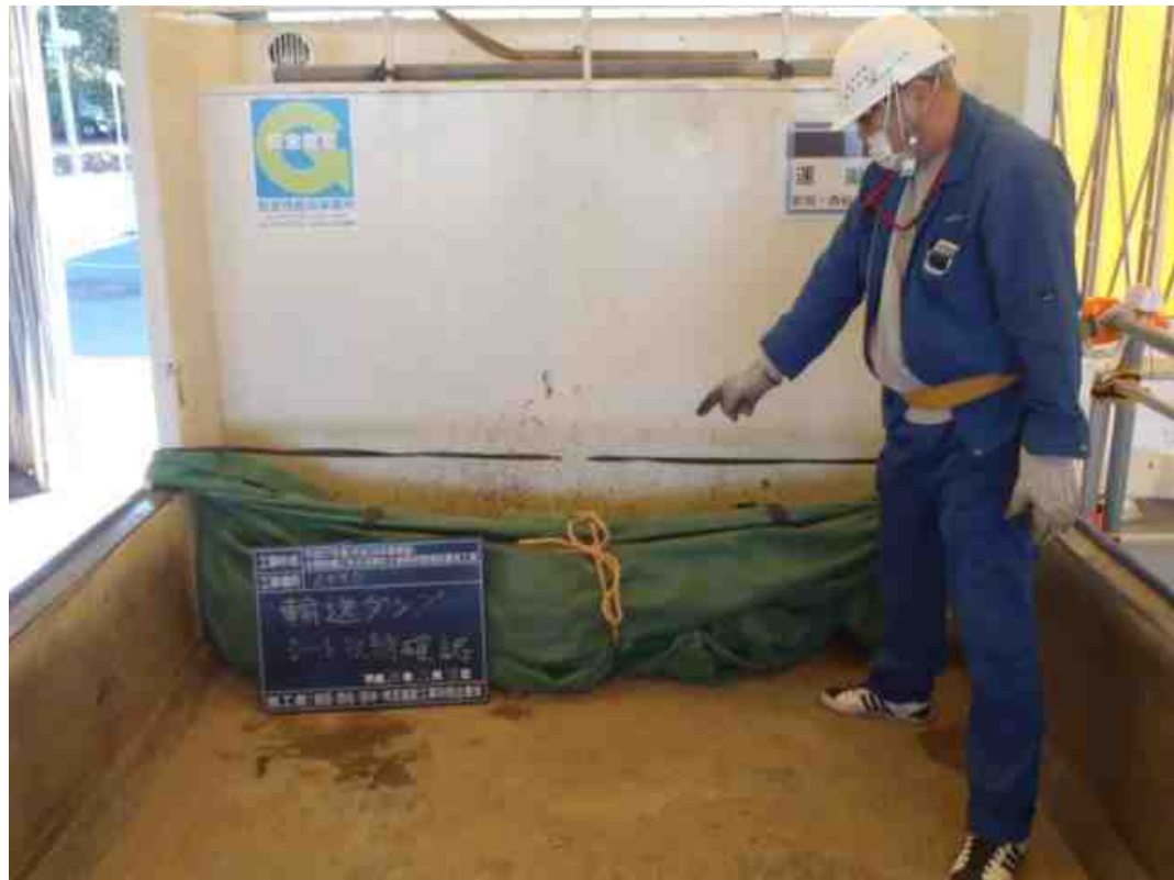
ダンクシート固縛の状況
