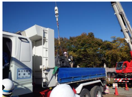
除去土壌等の車両積込状況確認
