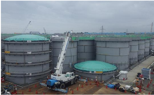
写真4：フランジタンク解体工事
