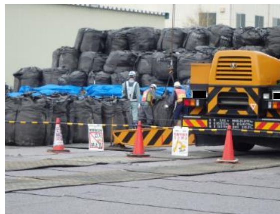
除去土壌等の積下ろし作業確認
