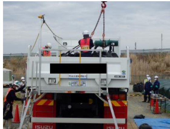
除去土壌等の積み込み作業確認
