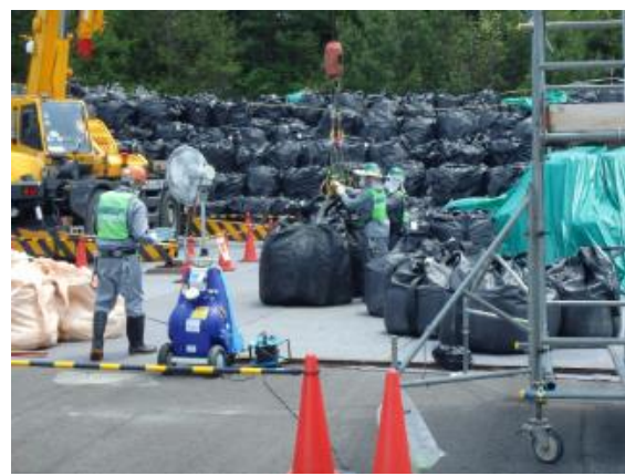
除去土壌等の積下ろし作業
