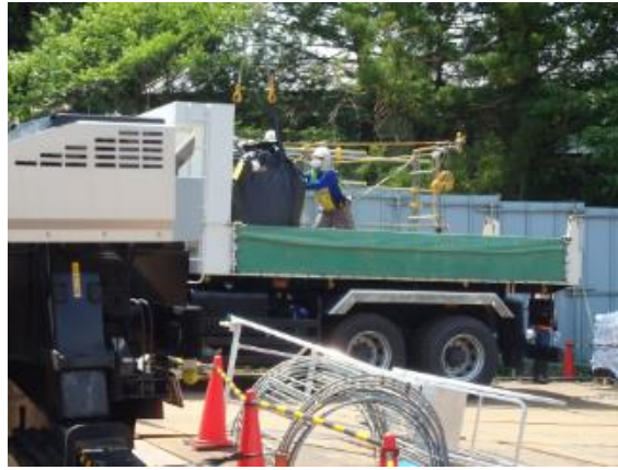
除去土壌等の積み込み作業
