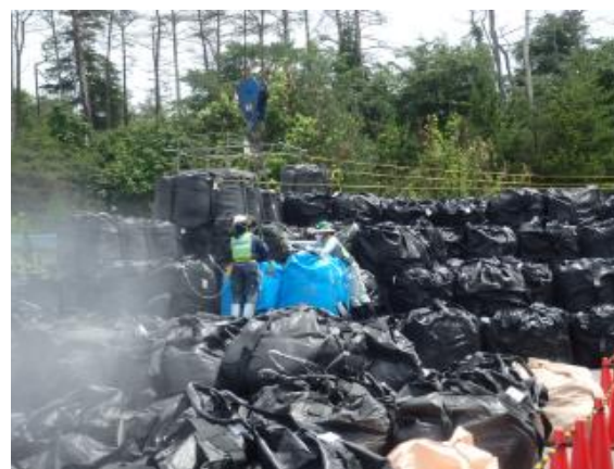
除去土壌等の積下ろし作業確認
