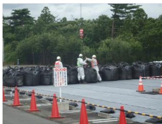
除去土壌等の積下ろし作業
