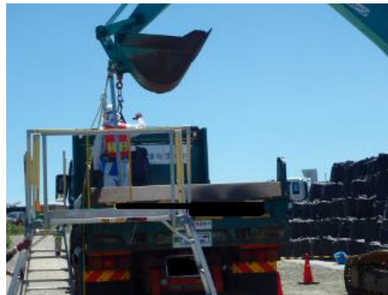
除去土壌等の積み込み作業
