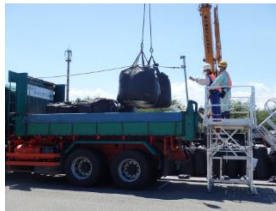
除去土壌等の積下ろし作業
