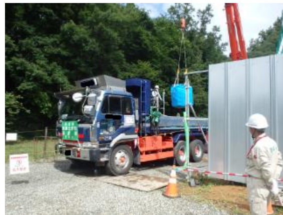
除去土壌等の積み込み作業
