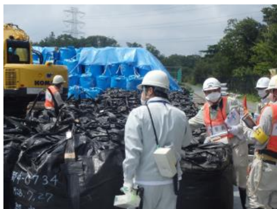
除去土壌等の保管状況確認
