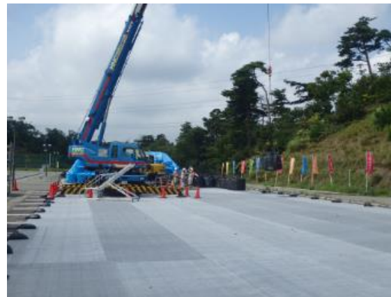
除去土壌等の積下ろし作業確認
