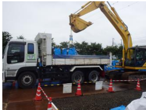
除去土壌等の積み込み作業確認
