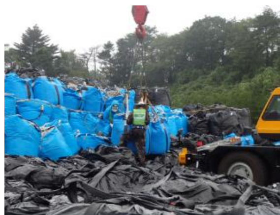
除去土壌等の積下ろし作業確認
