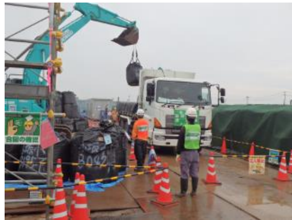
除去土壌等の積み込み作業確認
