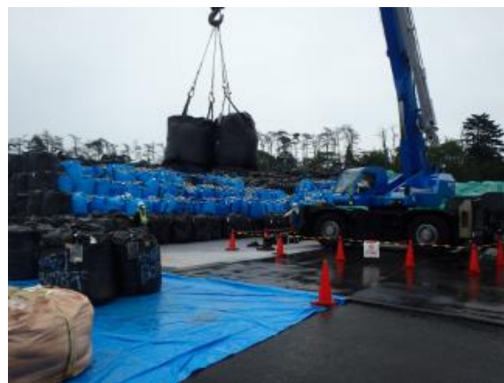
除去土壌等の積下ろし作業確認
