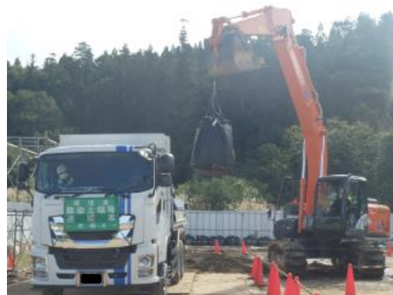
除染土壌等の積み込み作業確認
