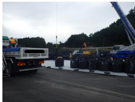
除染土壌等の積下ろし作業確認
