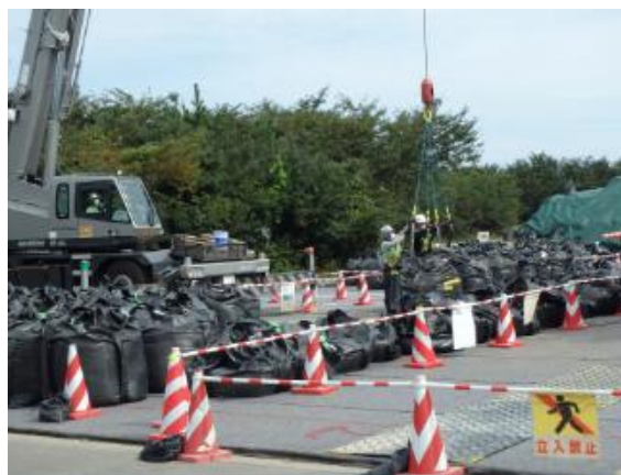
除染土壌等の積下ろし作業確認
