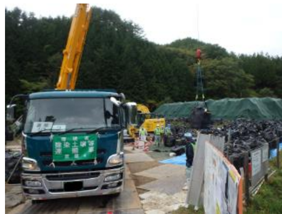
除染土壌等の積み作業確認
