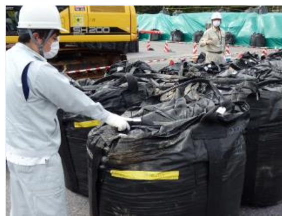
定置作業前のフレキシブルコンテナ確認
