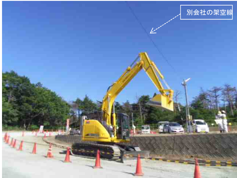
切断後の状況
