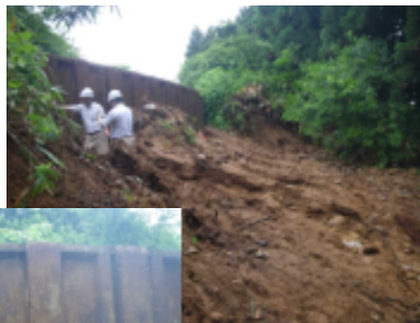
法面崩落による 水利施設破損
