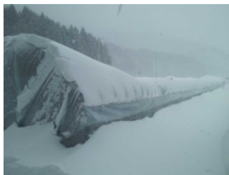
降雪で倒壊したパイプハウス
