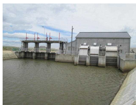
○排水機場の復旧状況
