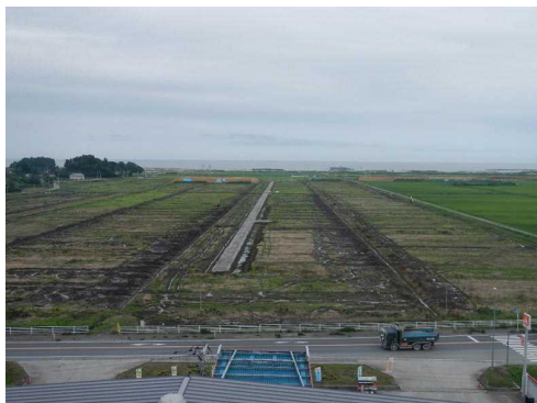
津波被災状況 (作田前地区（新地町）)
