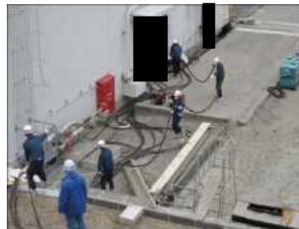
仮設ケーブルの布設の様子
