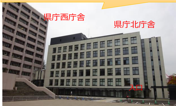
県庁北庁舎の外観
