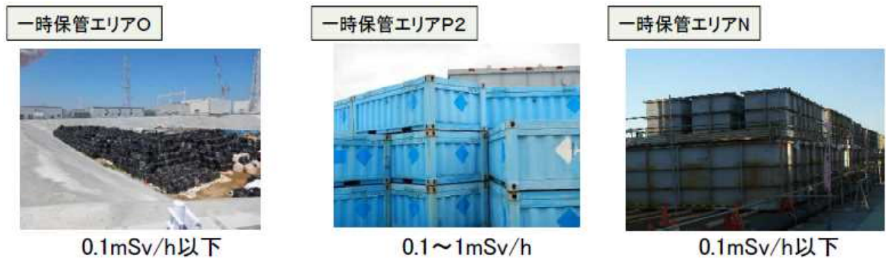
図20 現状の汚染土保管状況
