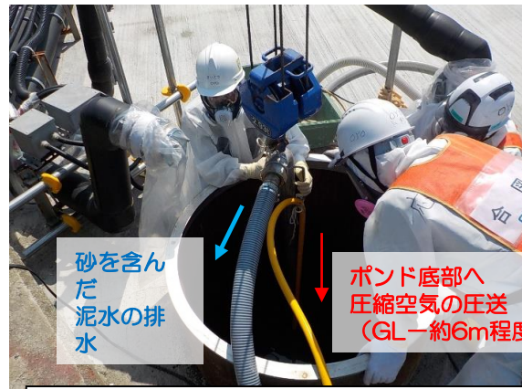
ポンドD清掃状況 （蓋（φ1100mm）を開口して、エアリフトを実施）
