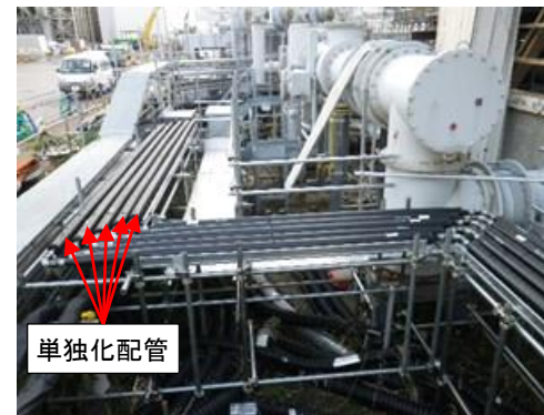
【中継タンクNo.4 北側】
