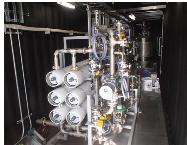
【コンテナ内部の状況】
