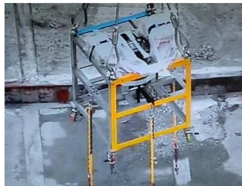
クレーンによる遠隔操作状況
