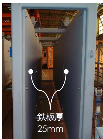
衝立形状⑤（鉛板マット取付前）
