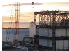
<2-3. 壁パネル取り外し作業の状況>
