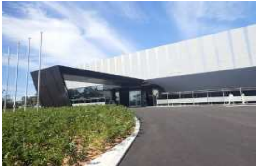
新事務本館外観
